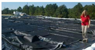
LAS Sludge Removal Project
